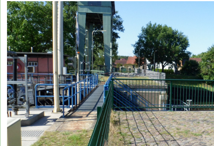
Blick auf die Wernsdorfer Schleuse
